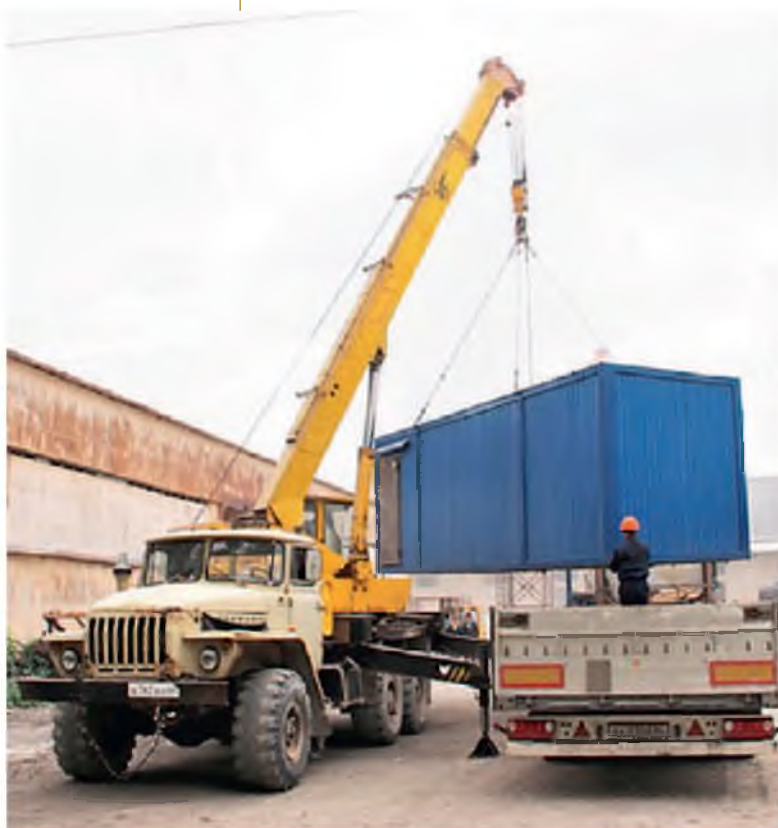
Погрузка блока станции на трейлер
