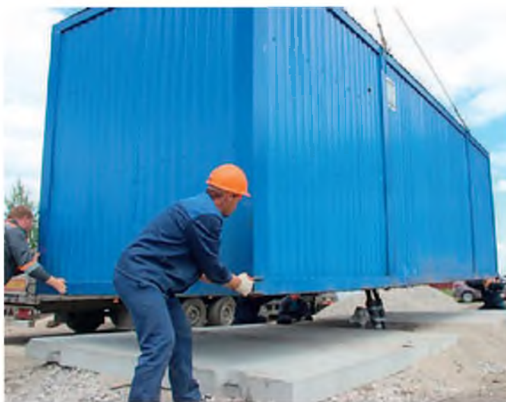
Установка блока станции на объекте. В качестве фундамента использованы стандартные дорожные плиты
